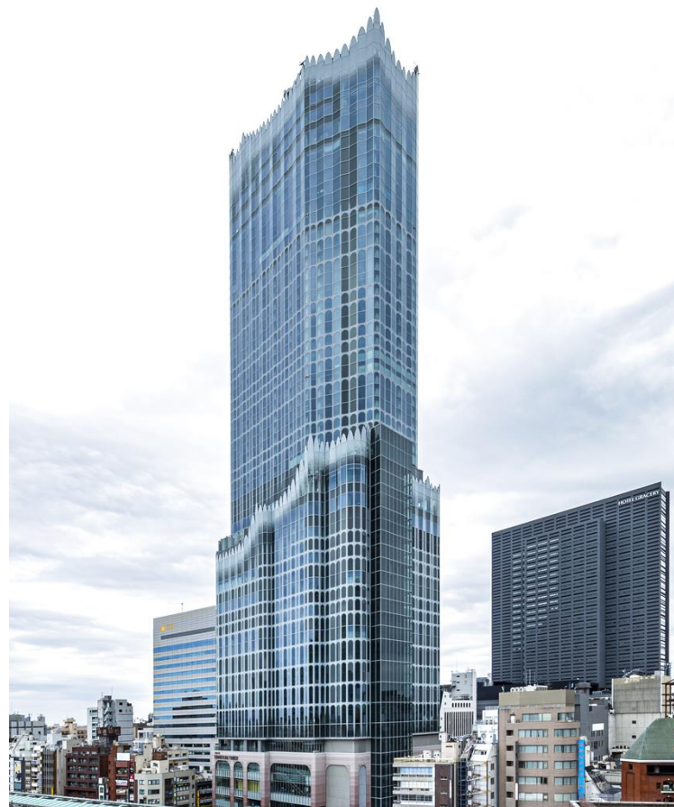
東急歌舞伎町タワー外観 （2022年10月時点）
