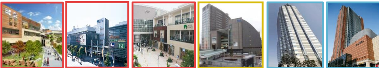
南町田グランベリーパーク (2019年11月開業) 青葉台東急スクエア (2000年11月開業) たまプラーザテラス (2010年10月全体開業) 二子玉川ライズ (2015年6月全体開業) 世田谷ビジネススクエア (1993年9月竣工) キャロットタワー (1996年11月竣工)
