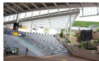
大階段下の雨水貯留施設と 高効率灌水設備の植栽帯
