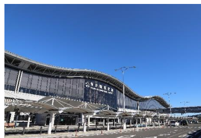
仙台国際空港 旅客ターミナルビル
