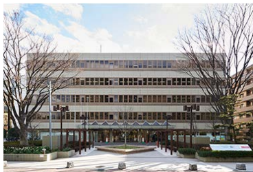
新溝ノロビル
