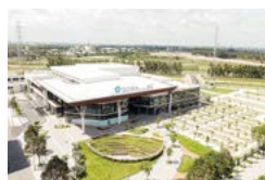
ベトナム・ビンズン新都心 商業施設「SORA gardens SC」
