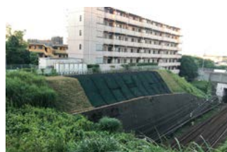
対策後の斜面（鶯沼駅～たまプラーザ駅）
