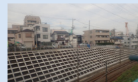
対策後の斜面 （池上線洗足池駅～石川台駅）
