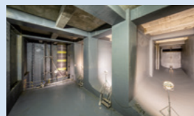
渋谷駅東口雨水貯留施設
