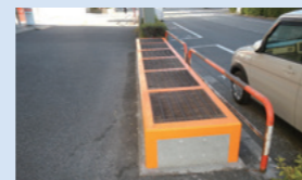
換気口かさ上げ工事 （田園都市線三軒茶屋駅～桜新町駅間）
