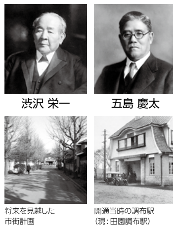
将来を見越した市街計画 開通当時の調布駅(現:田園調布駅)
