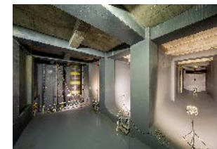
渋谷駅東口雨水貯留施設
