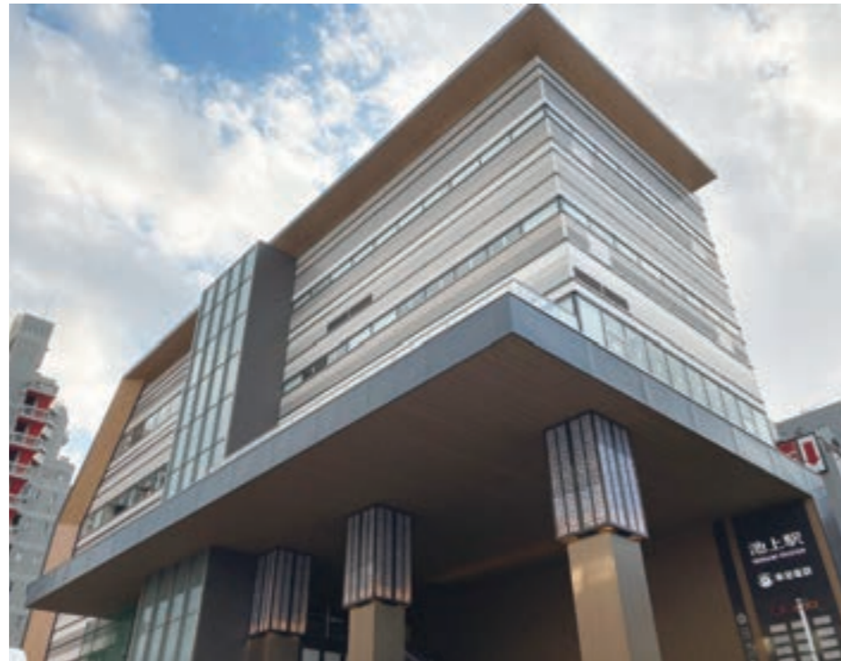
新しく生まれ変わった駅舎
