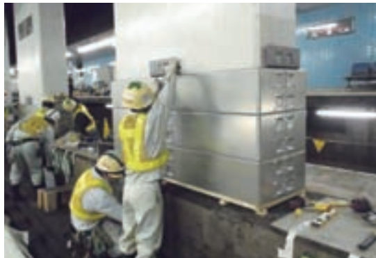
耐震補強工事
