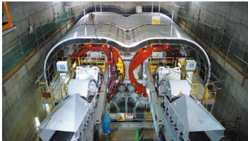
渋谷～代官山間地下化工事(同工事で活躍したシールドマシン)
