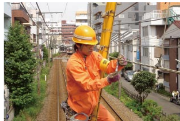
電気係員が電車線の状態を確認
