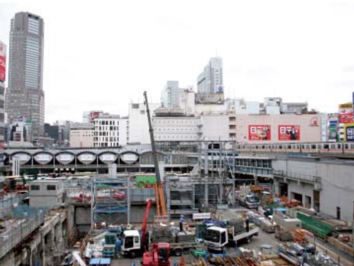
東急文化会館跡地工事現場(平成20年3月撮影)
