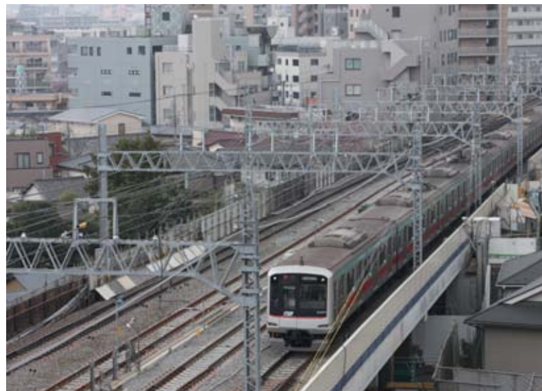
二子玉川~溝の口間の複々線化工事(平成 21 年 4 月撮影)
