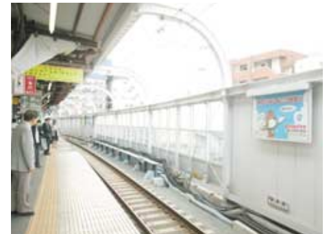
工事中の旗の台駅(大井町線)
