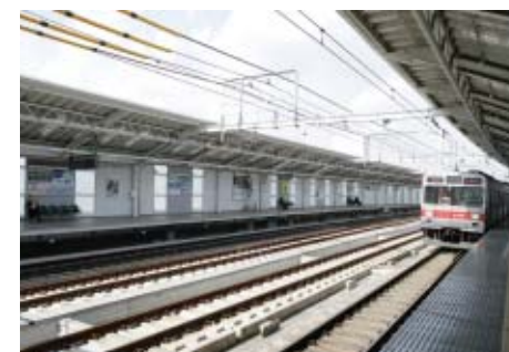
二子玉川～溝の口間の複々線化工事(二子新地駅)
