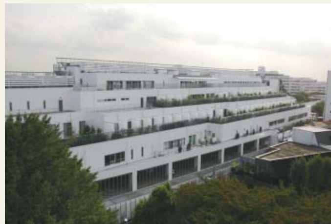
日本初の駅上病院 東急病院
