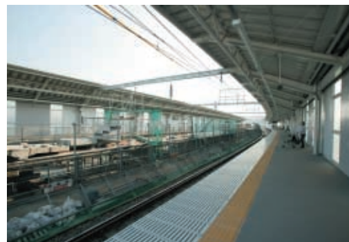
複々線化工事が進む田園都市線二子新地駅
