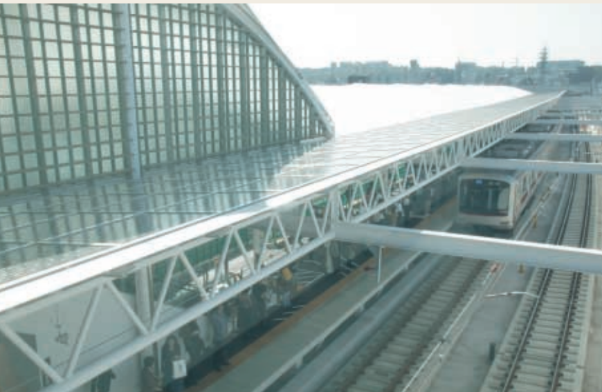
太陽光発電システム(ホーム屋根)
