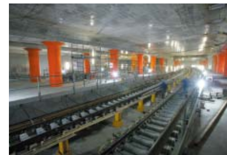
渋谷～代官山間地下化工事
