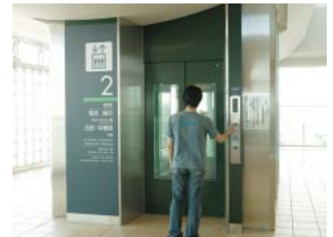
エレベータを設置した元住吉駅
