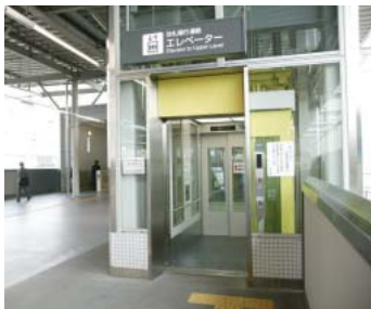
新設したエレベーター（二子玉川駅）
