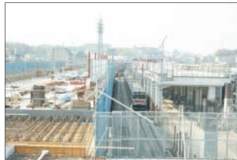
武蔵小杉～日吉間線増工事
