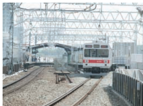
二子玉川～溝の口間複々線化工事(二子新地～高津間)
