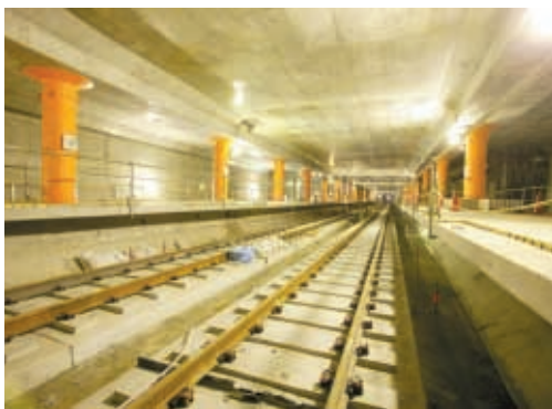
目黒線目黒～洗足間立体交差工事(武蔵小山駅)
