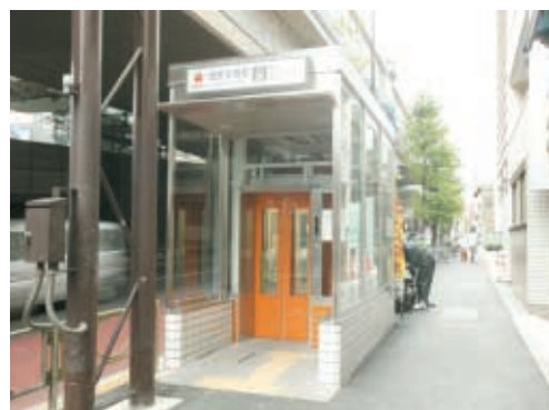
新たに設置したエレベーター(池尻大橋駅)
