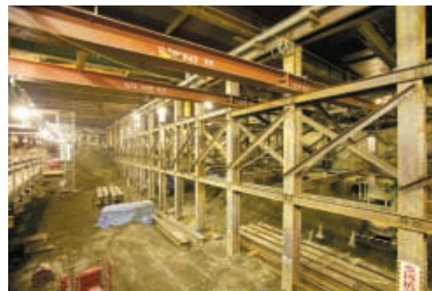
渋谷～代官山間地下化工事
