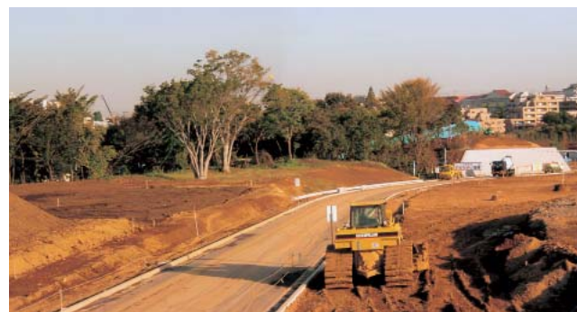
自然を活かして工事が進む犬蔵土地地区画整理事業(左奥が公園予定地)
