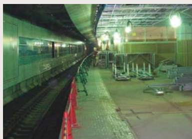
地下5階に設置されるホーム
