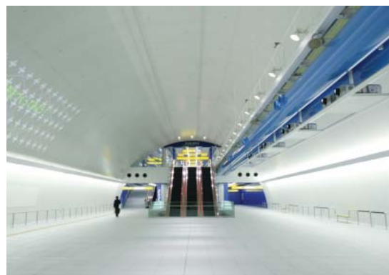
コンコース(横浜高速鉄道 みなとみらい駅)
