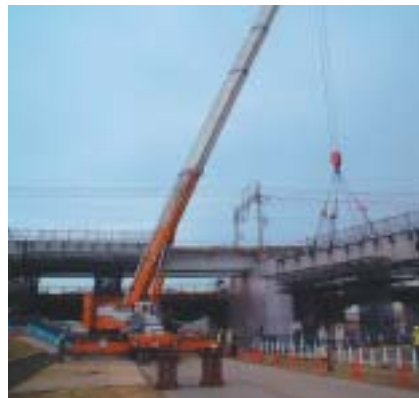
二子橋梁橋脚拡幅工事(二子新地駅付近)
