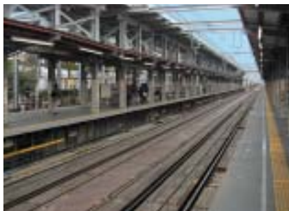
高架橋構築工事(元住吉駅)
