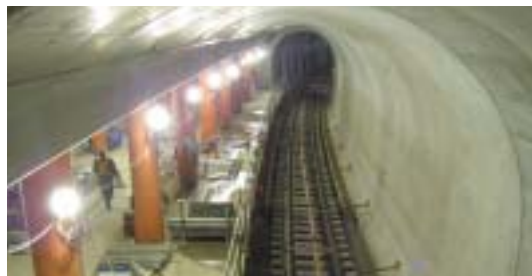
反町駅地下での工事状況
