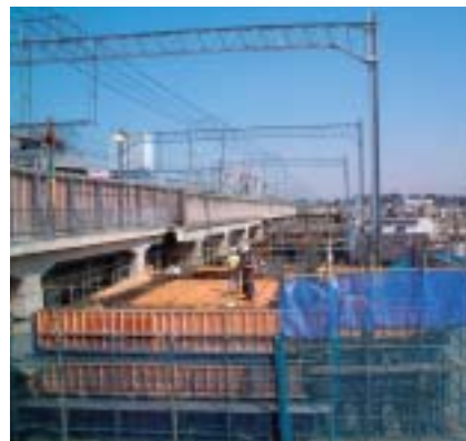
高架橋拡幅工事(二子新地～高津間)
