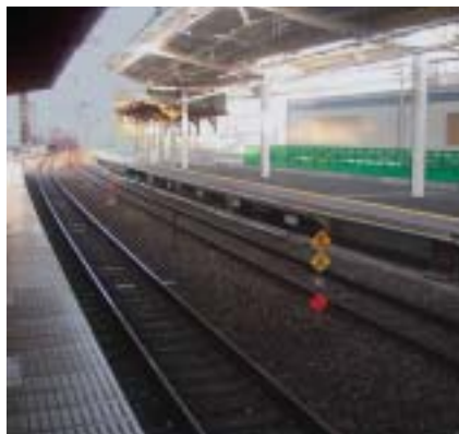
仮設ホームを設置した溝の口駅下りホーム(右奥)
