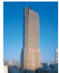
セルリアンタワー東急ホテル
