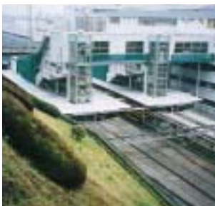
増床したコンコースと新設エレベーター(外観)
