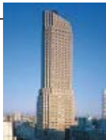
セルリアンタワー東急ホテル
