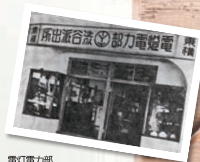
電灯電力部 渋谷駅前の渋谷派出所
