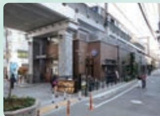
都立大学駅 高架下商業施設
