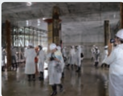
工事中の東口地下広場の様子
