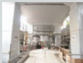
耐震補強を進めている高架橋
