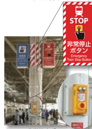
ホームの非常停止ボタン
