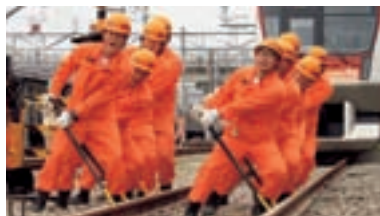
保線係員が線路を正常な状態に修正
