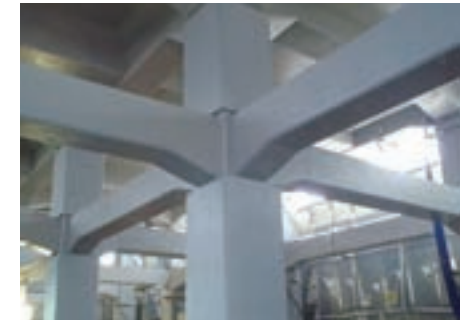
高架橋耐震補強工事
