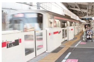
ホームドア整備
