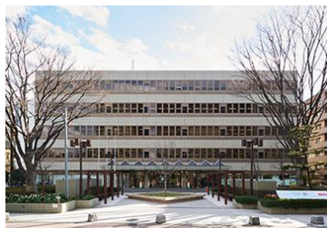
新溝ノロビル
