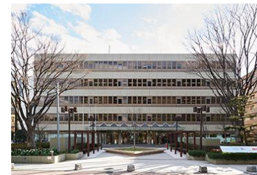
新溝ノロビル
