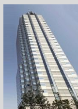
世田谷ビジネススクエア* (1993年9月竣工)
