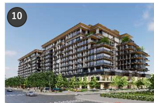
The TEN (施工中)
