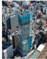
工事進捗状況
