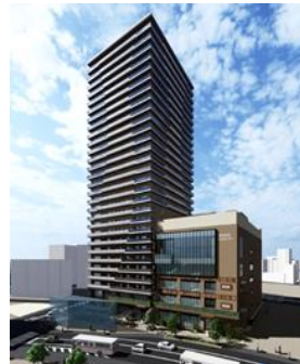
新綱島駅前地区 第一種市街地再開発事業 (2023年度竣工予定)
