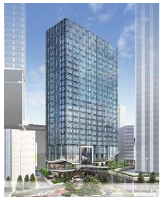
「渋谷二丁目17地区市街地再開発事業」 (ZEB Oriented認証取得)
