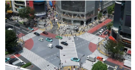
路面の温度上昇を抑制する舗装
