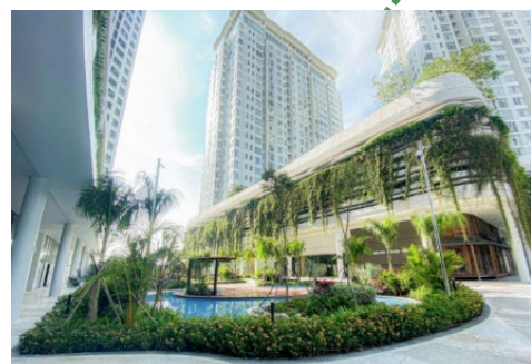
2021年竣工 SORA gardens II
