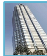
世田谷ビジネススクエア (1993年9月竣工)
