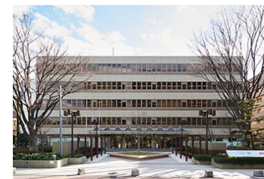
新溝ノロビル
