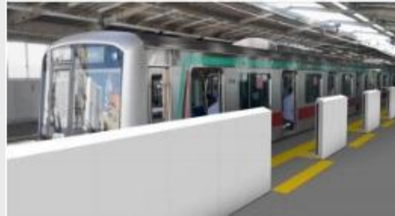
安全性・利便性の向上
