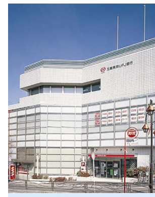
第2東急鷺沼ビル
