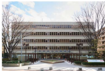
新溝ノロビル
