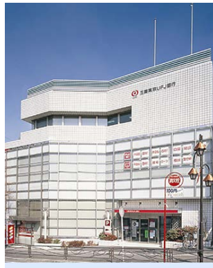
第2東急鷺沼ビル
