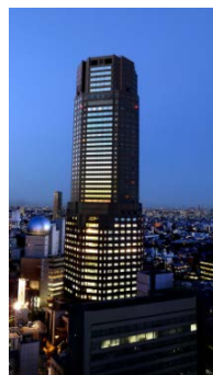
セルリアンタワー 東急ホテル
