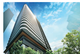
ドレッセタワー武蔵小杉 外観イメージ
