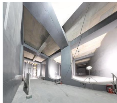
▲渋谷駅東口雨水貯留施設の内部
